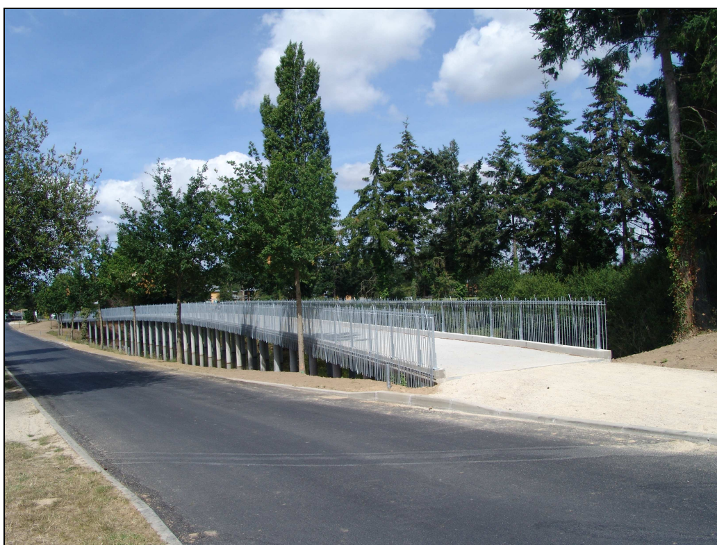
Photographie 30 : Construction sur pilotis d'un pont d'accès au village résidentiel de tourisme le "Hameau de la Chaize" (Crédit photographique : Janique Valy, le 06/07/2010)
