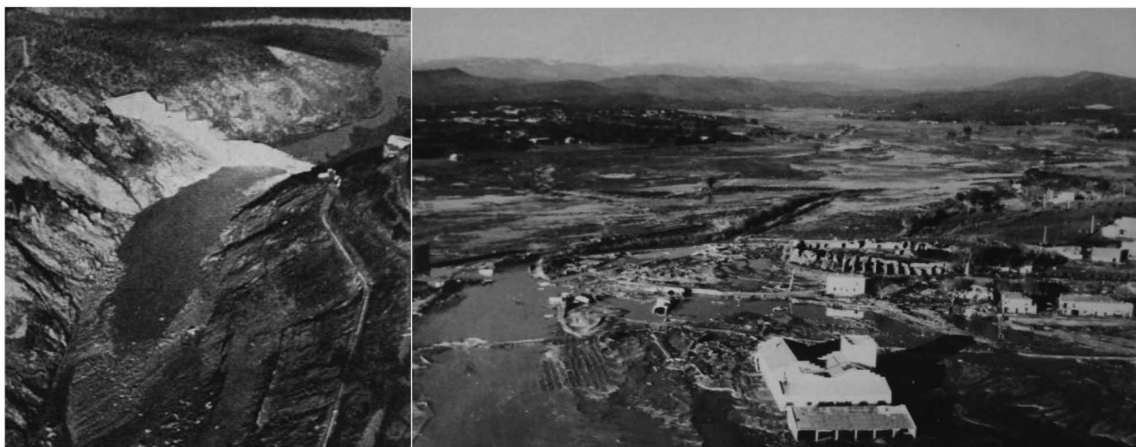
Figure 5 : Rupture du barrage de Malpasset le 2 décembre 1959 : a/ le barrage juste après sa rupture ; b/ la plaine de Fréjus juste après le passage des eaux (source : Musée local de Fréjus).
