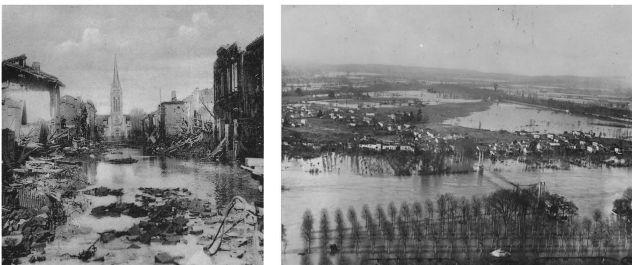
Figure 2 : Crue de mars 1930 : (a) Le village de Reynies après le passage des eaux ; (b) Agen à la confluence entre la Garonne et le Tarn (sources : DDT82 et Aquadoc).
