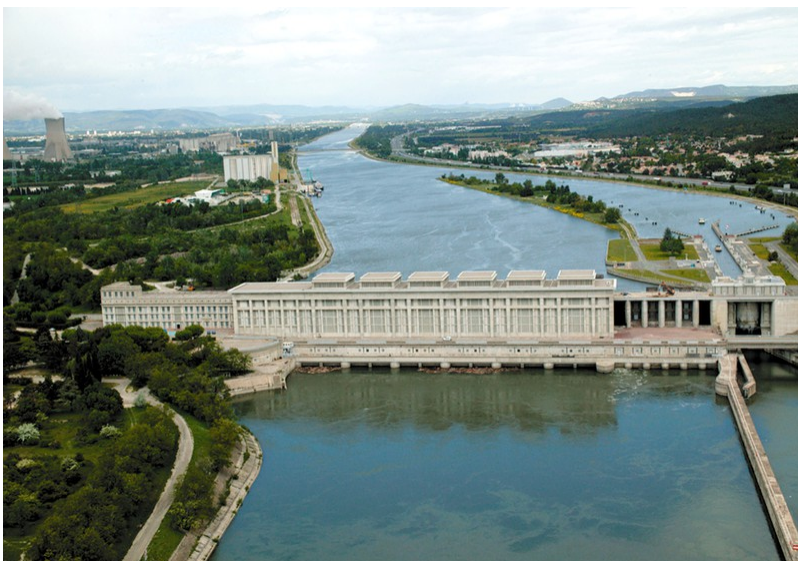
Barrage de Donzère-Mondragon 350 MW
