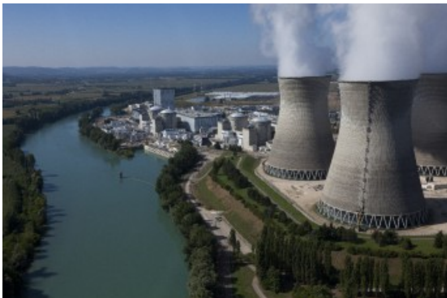
Centrale nucléaire de Bugey 4 x 900 MW
