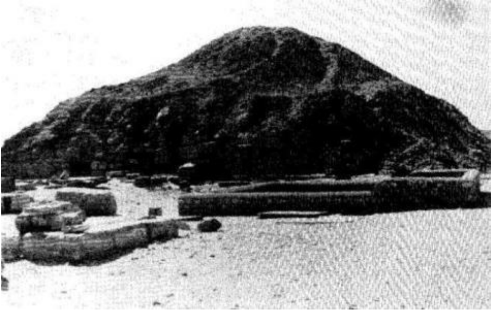
La pyramide ruinée d'Unis à Saqqarah, montrant l'indigence des techniques de construction employées sur le site.
