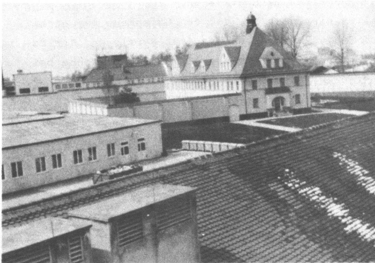
Haus III Station für Betonspritzen
