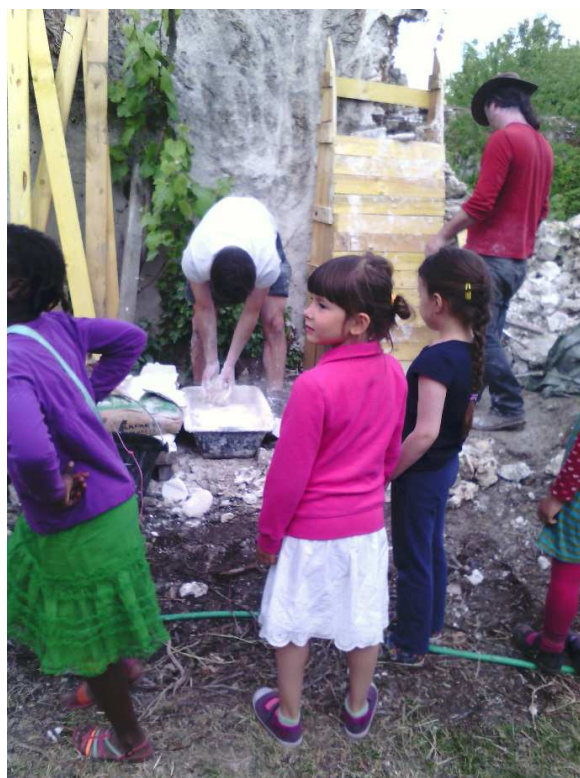
rénovation d'un mur lors du festival des murs à pêches
