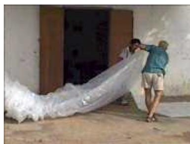
**Photo 3.** Colocando um tubo de plástico dentro doutro para dar mais força
