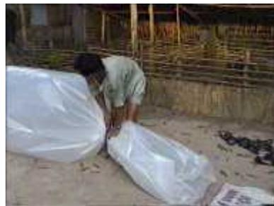
**Photo 7.** Amarrando o tubo mas deixando plástico para colocar o tubo de saída.
