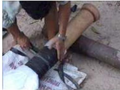
**Photo 5.** Colocando as borrachas em volta do tubo de plástico e o tubo cerâmico
