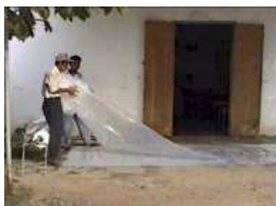
**Photo 2.** Juntando um tubo de plástico em preparação de colocar dentro doutro.
