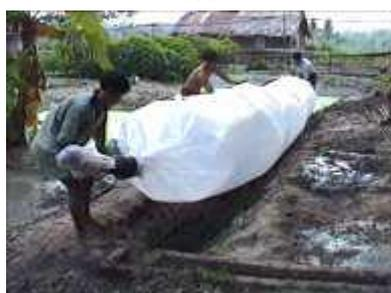
**Photo 10.** Colocando o biodigestor no fosso
