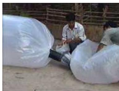
**Photo 9.** Forçando o ar do pequeno tubo para o biodigestor
