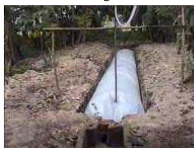
**Photo 11.** Connectando o tubo PVC para a saída de gás
