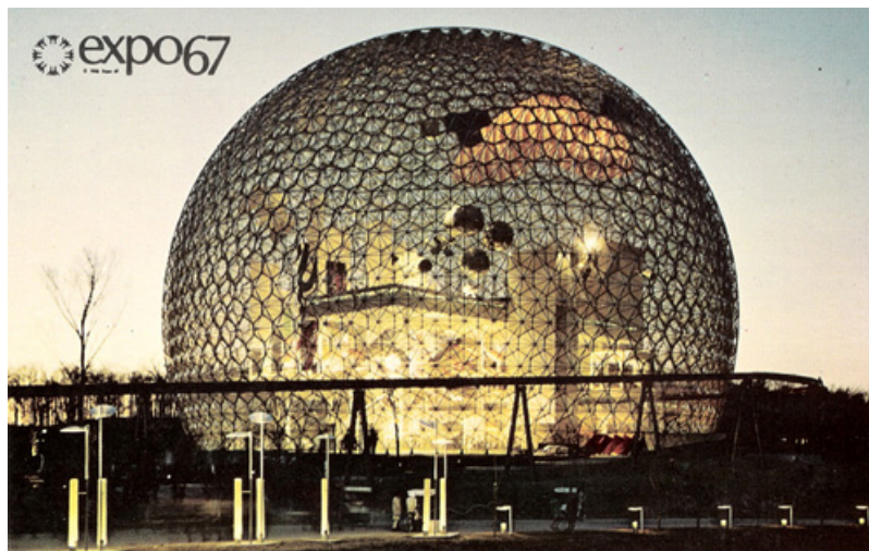
Domo Geodésico feito para a Expo 67 em Montreal
