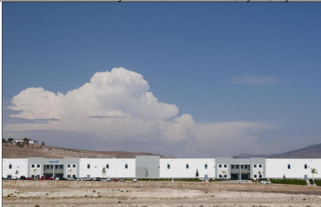
Foto N° 4. Parte frontal del Conjunto industrial Valle Bonito, Tijuana, Baja California
