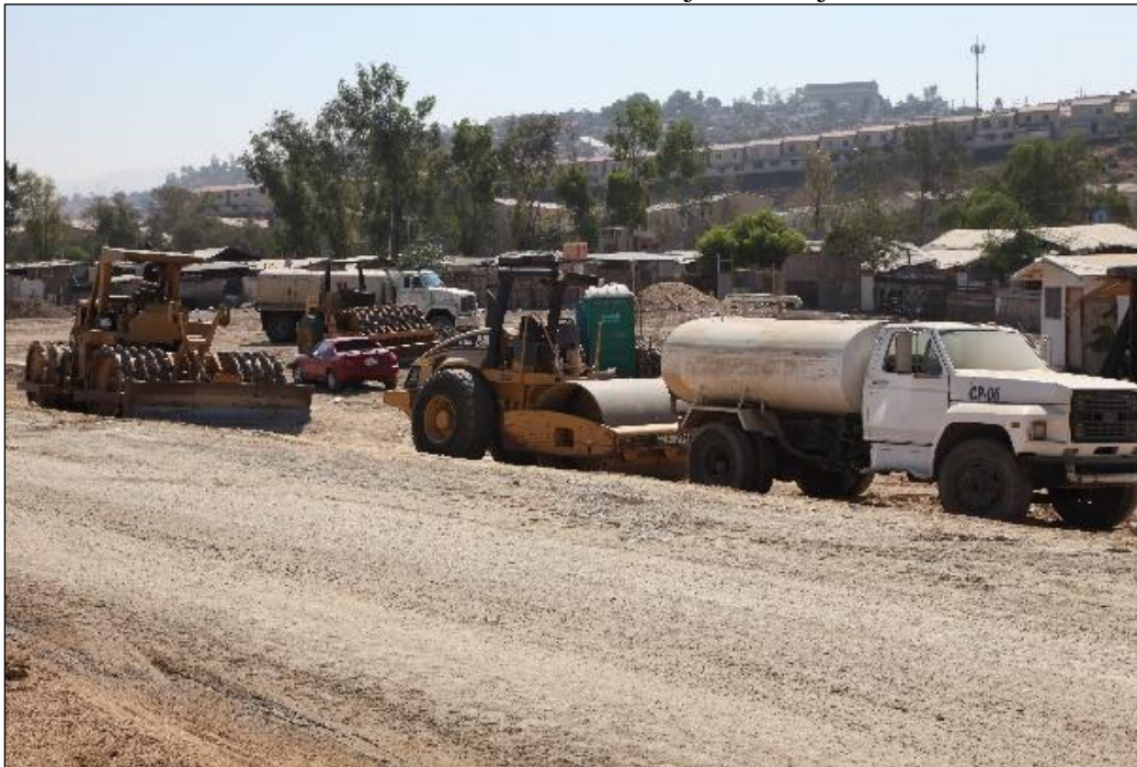
Foto N° 6. Vista de las obras en construcción, Tijuana, Baja California
