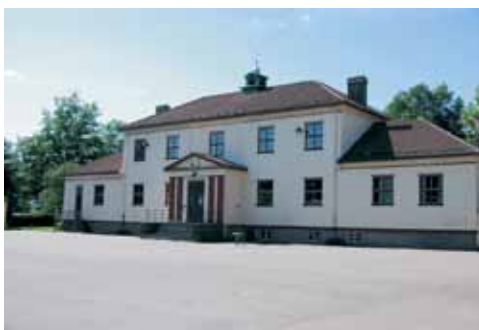
Grindløkka skole har en særegen byggestil, og bør bevares.
